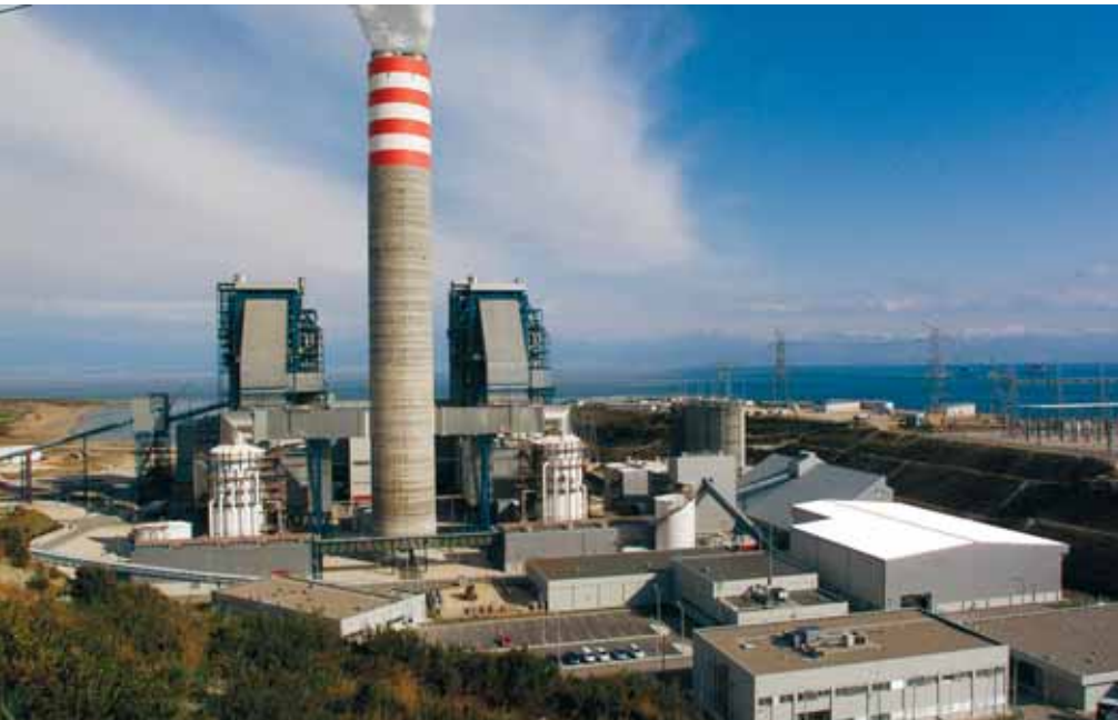
İSKEN Termik Santrali, Yumurtalık
